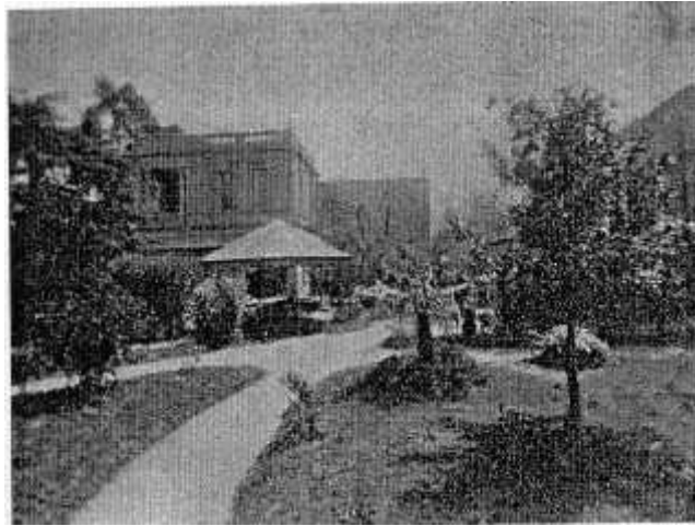
Figura 2.26. Fotografía del antiguo ingreso en 1905, en dirección por la actual avenida Avellaneda (Martinez,2005)
