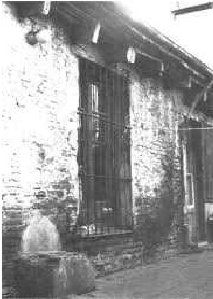
Figura 2.30. Fotografía, de la década de 1970, de la pared del fondo que daba al jardín, donde se observan ladrillo y tirantes de madera de una construcción típica colonial. (Cunietti Ferrando (1991)
