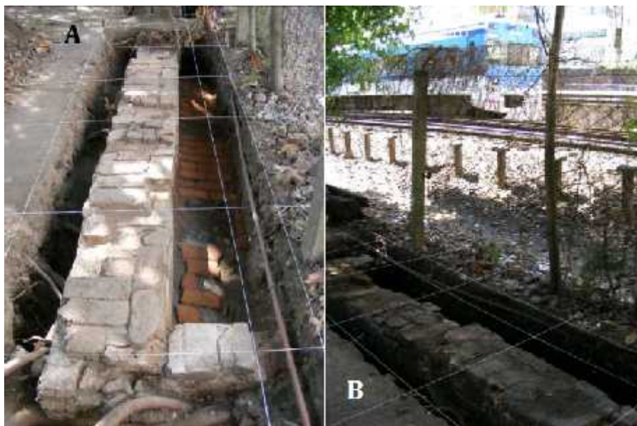
Figura 2.14. Fotografías realizadas durante la excavación del muro y piso de ladrillos hallados en el sitio Rodríguez Visillac (Camino, 2012)
