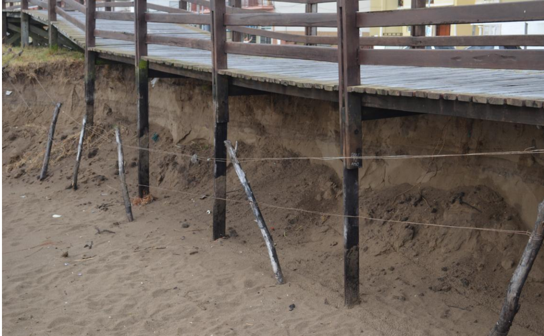
Figura 62: Erosión Costera en Santa Teresita, pasarelas de madera. 2011 Fuente R.Trus
