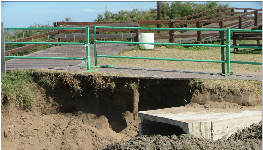
Figura 46: Mar del Tuyú 2010. Destrucción de sistema de desagüe debido a erosión. Vista hacia el norte. Fuente Ruth Maricel Trus
