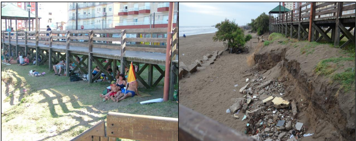
Figura 63: Izquierda, Pasarelas de madera en sector playa de Santa Teresita. 2008, Derecha, nótese los metros de playa destruidos al 2011. Fuente propia. Calles 32 a 35 y Av Costanera. Fuente Ruth Maricel Trus
