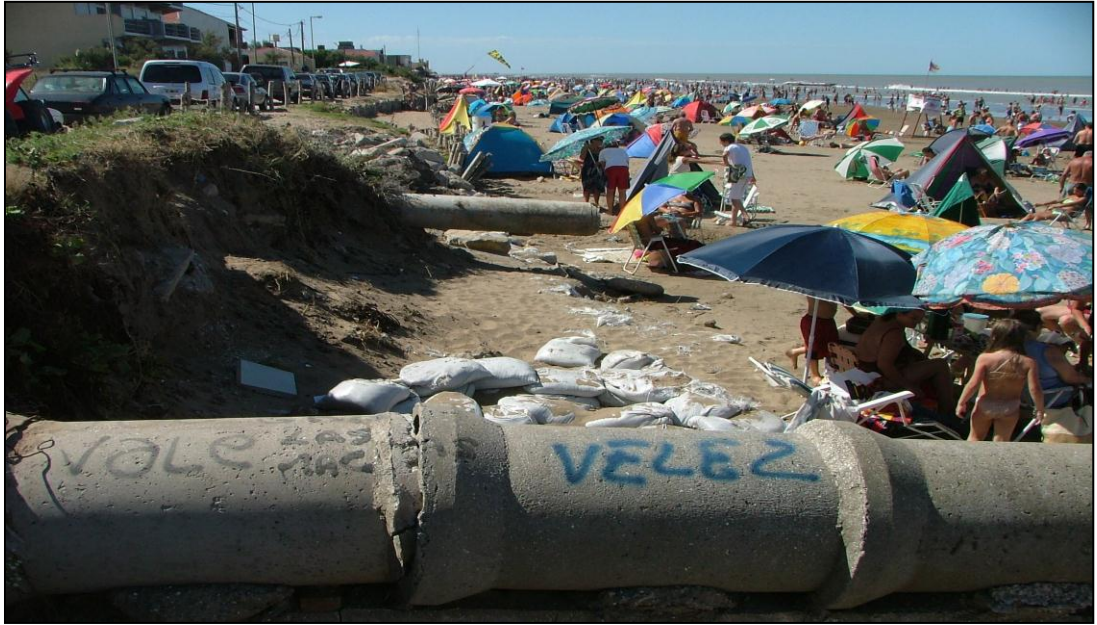
Figura 46: Mar del Tuyú 2010. Destrucción de sistema de desagüe debido a erosión. Vista hacia el norte. Fuente Ruth Maricel Trus
