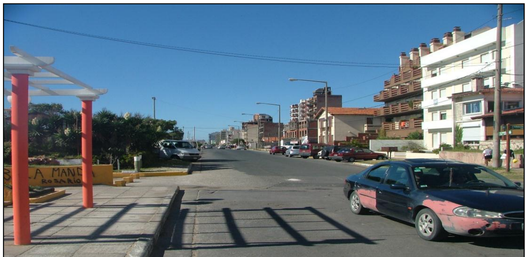
Figura 33: San Bernardo 2010. Av Costanera. Edificaciones costeras. Vista hacia el sur. Fuente Ruth Maricel Trus
