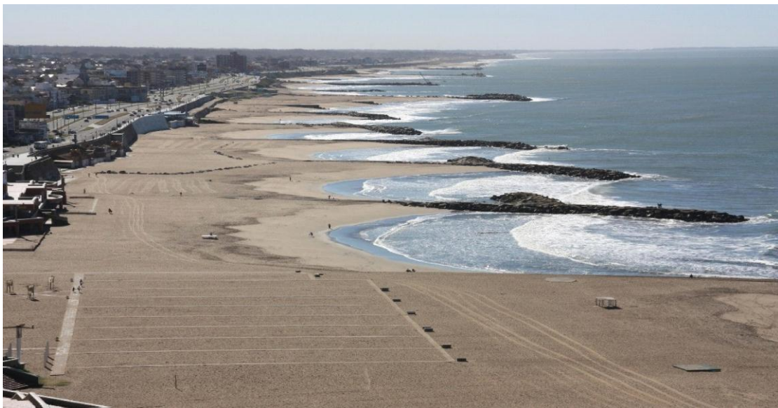
Figura 57: Playas al norte del Puerto de Mar del Plata. Espigones como obra de defensa, para proteger la playa de erosión. 2009. Los sedimentos entrampados generan déficit de arena aguas abajo, según la deriva litoral.
