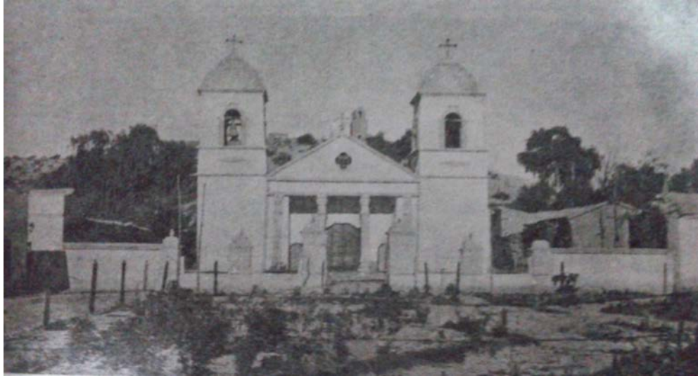
Imagen de la Iglesia de Humahuaca (circa 1907) donde se ve la plaza y el lateral, a la derecha de la imagen, que ocupaba la iglesia antes de la construcción del monumento. Fuente: Solari (1907:55)
