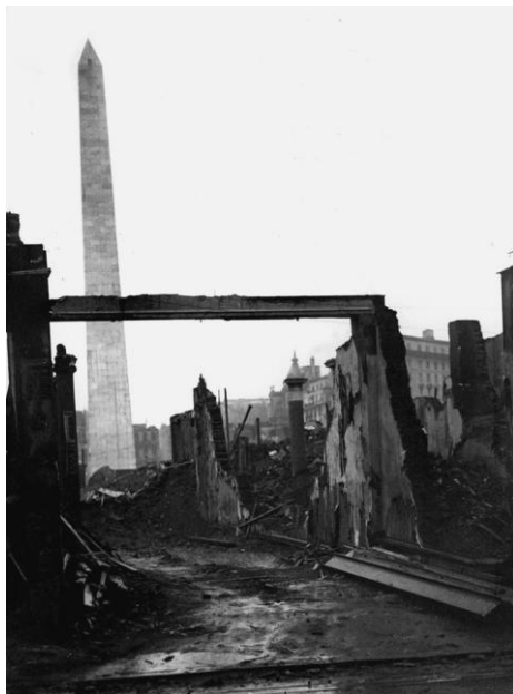
104. Demoliciones para el ensanche de la calle Corrientes, 1936 (foto AGN)
