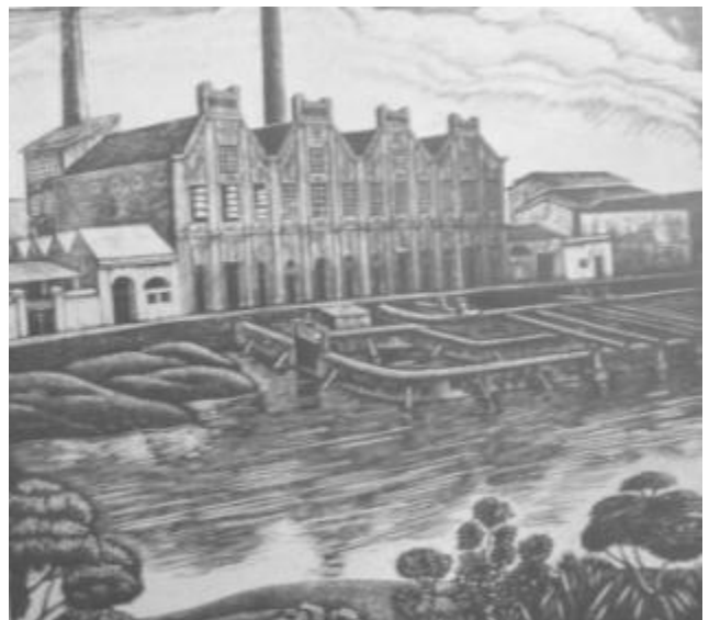
17. Alberto Nicasio. Usina de electricidad . XXV Salón, 1935
