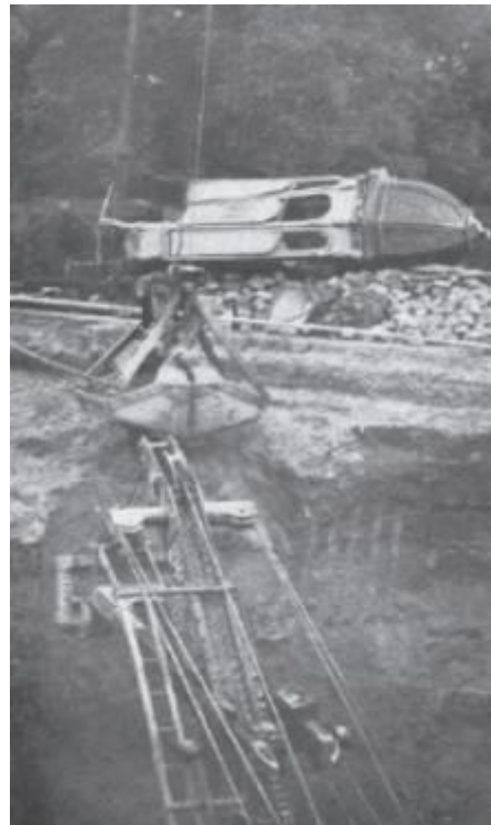
98. "Cómo se construye el subterráneo", Caras y Caretas , n°694, 1912
