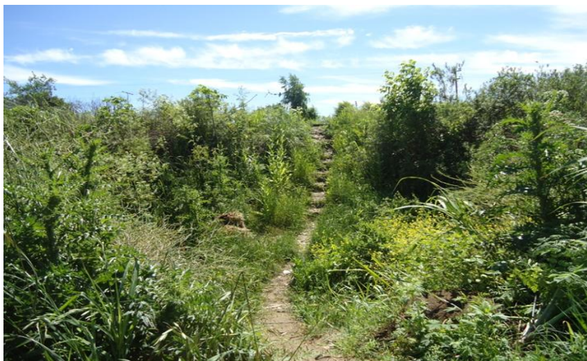
Foto 9 Una de las sendas peatonales que cruza el terraplén desde la villa hasta la calle paralela a la autopista.
