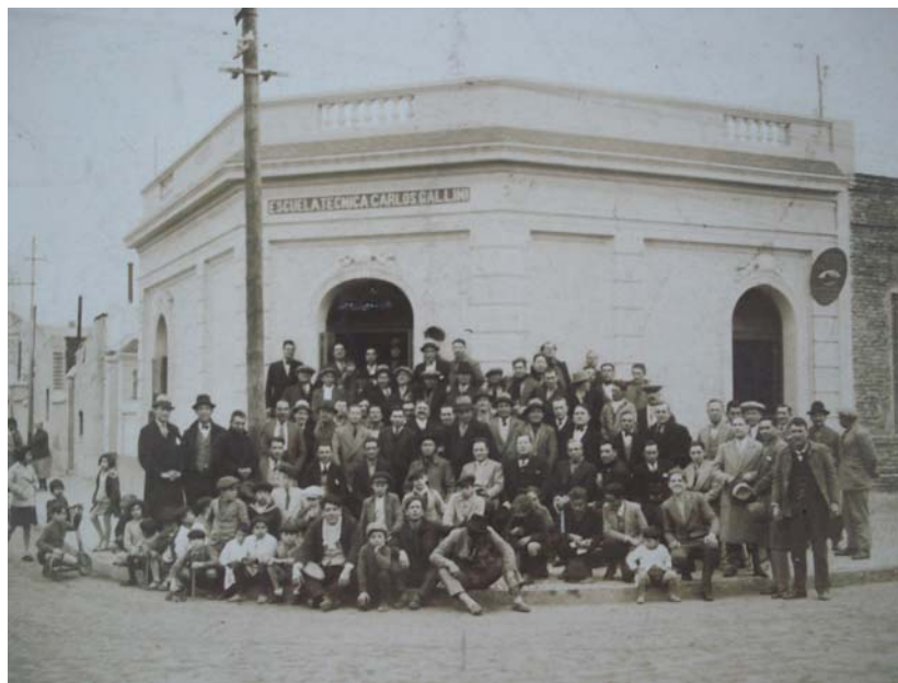
Imagen 11: “Inauguración de la casa propia para la Escuela Técnica “Carlos Gallini”. Rosario, 1931
