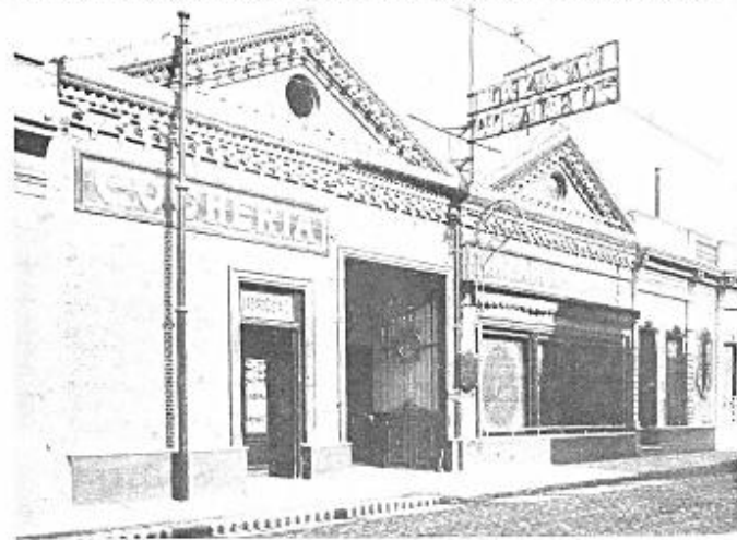
Frente del edificio
