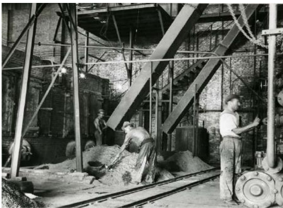
Figura 34. Sala de calderas: aserrín cocido y exprimido (desechable) llegaba por medio de cintas a esta sala, y se reutilizada como combustible para producir vapor necesario que hacía funcionar las maquinarias de la fábrica. Archivo General de la Nación
