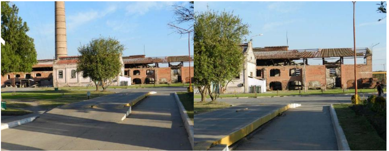
Figura 45. Edificio de la antigua fábrica de tanino La Forestal, ubicada en el predio de la actual fábrica “Tableros Guillermina”. División Guillermina de Ferrum S.A.
