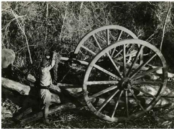
Figura 24B. Trabajador en el monte utilizando alzaparilla para subir los rollizos al carro cachapé. Archivo General de la Nación.
