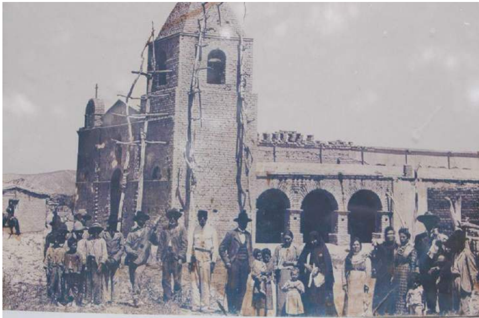
Foto ca. 1895, en la cual se puede ver pobladores de Amaicha y la iglesia en construcción.
