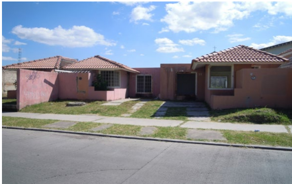
Figura 7. Casas en abandono sobre la vía de acceso principal al fraccionamiento Los Silos. Fuente: Carmen Barranco, octubre 2014.
