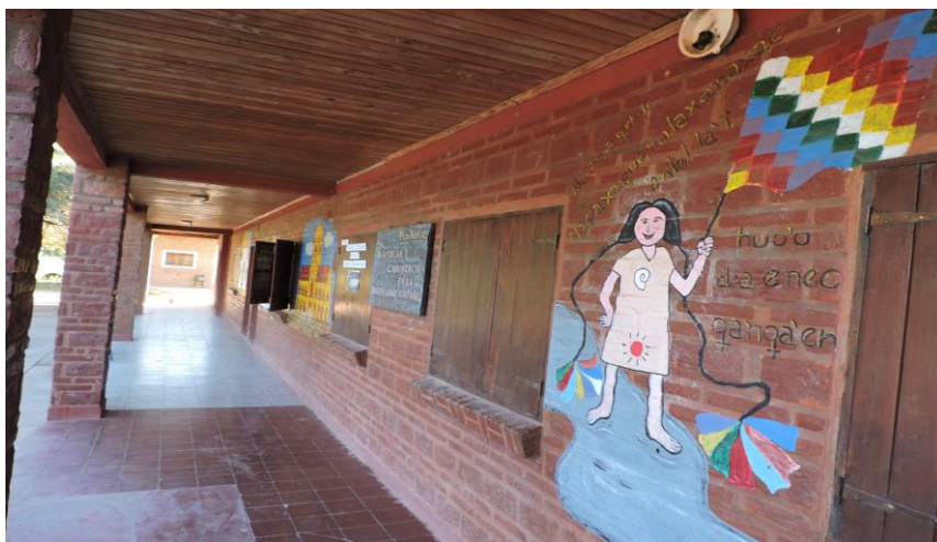
Fotografía 7: Pasillo de la escuela primaria.
