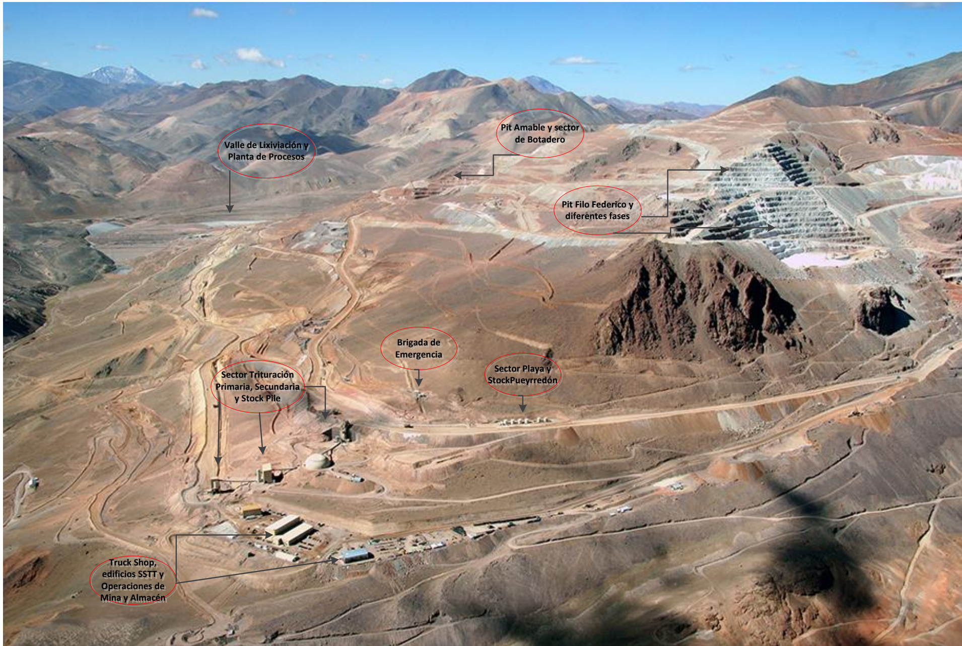
Fotografía 14 .Vista aérea de un sector de la mina Veladero e indicaciones de los espacios productivos.
