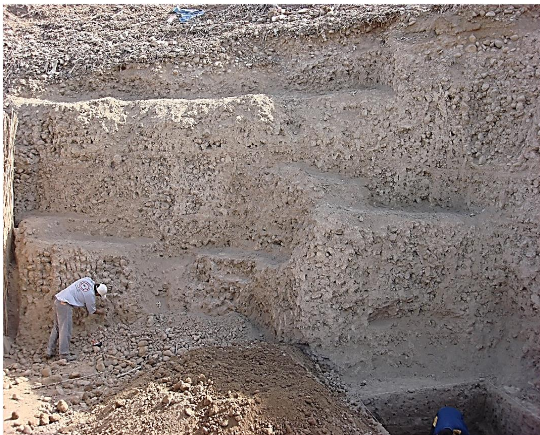
Figura 5. Vista del perfil ubicado hacia el sector sur de la huaca, cuyo corte fue realizado por los mismos habitantes del lugar.
