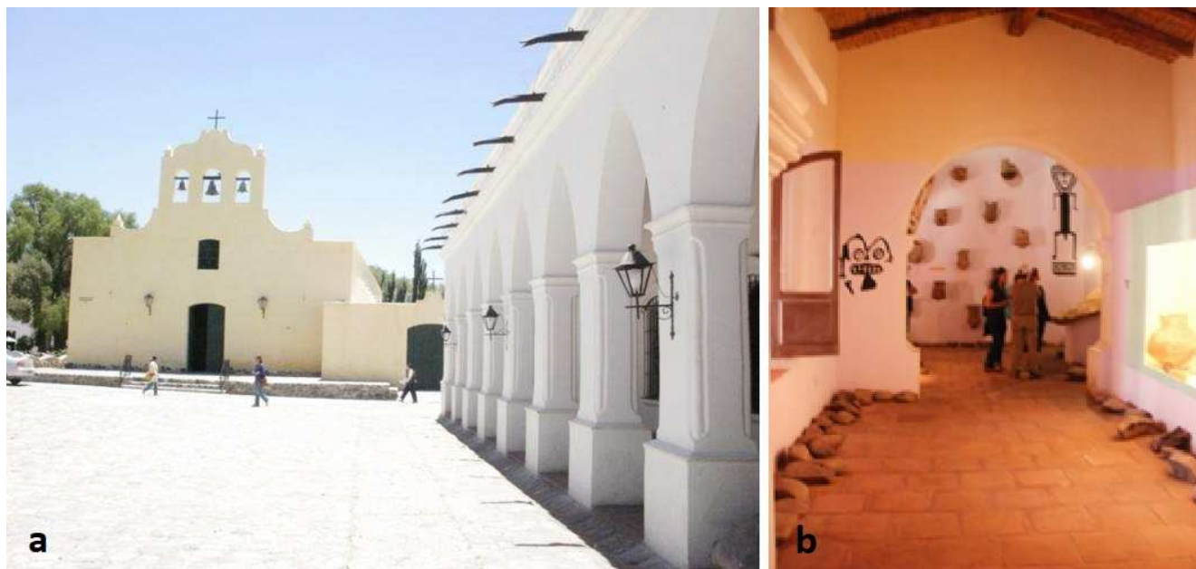
Figura 4. a. Frente remodelado del edificio del Museo Arqueológico de Cachi e Iglesia conservada de Cachi. b. Vista de salas de exposición intercomunicadas por arcadas.
