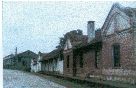
Fig. 56 Viviendas para el personal técnico
