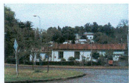
Fig. 59 Cuartos para capataces
