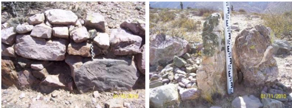
Figura 5.13. Izq.: Muro con escasa presencia de líquenes y de una sola especie, considerado como una construcción más moderna. Der.: Estructuras con abundantes líquenes de tres especies diferentes, probablemente de mayor antigüedad.
