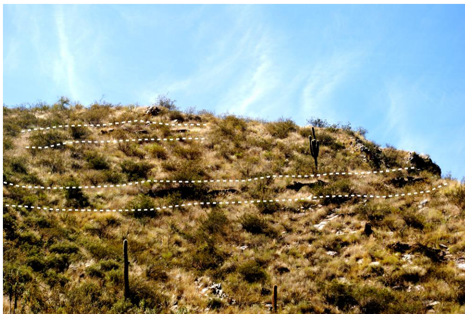
Figura 4.12. Sector XIV, muros defensivos medios y bajos vistos desde el conjunto bajo del sector XIV.
