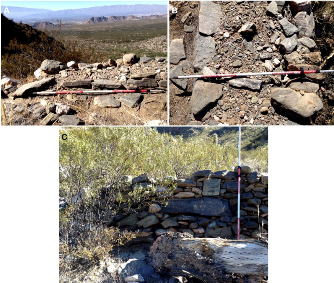
Figura 7.9. Muro 1 del Recinto 104 del sector XII 6 . A. Foto de frente en dirección Noreste-Sudoeste. B. Foto de planta en dirección Sudeste-Noroeste. C. Foto de frente en dirección Sudoeste-Noreste.
