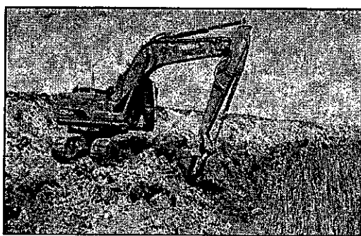
Foto N°6: Movimiento de suelo con pala mecánica
