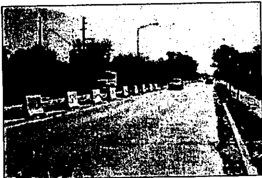
Foto N° 5: Ensanche y repavimentación de la R.P.N. 27
