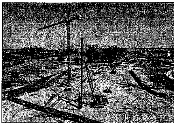
Foto N° 8: Pilotaje de fundaciones para el Hotel Intercontinental, Nordelta
