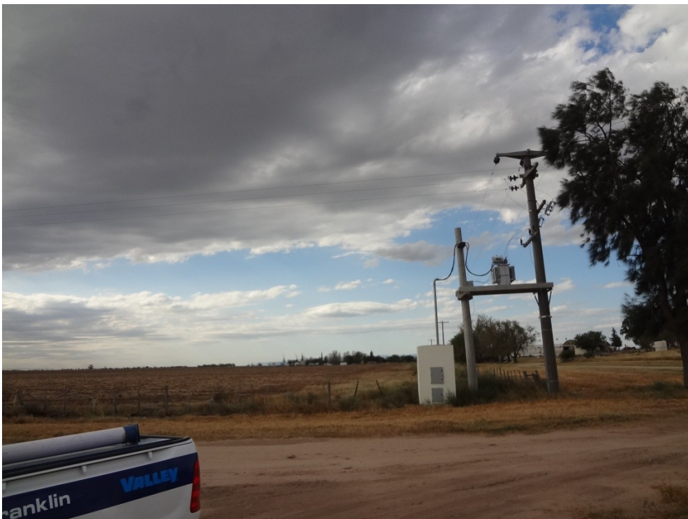
Foto 3: Extensión de tendido eléctrico para la instalación del riego
