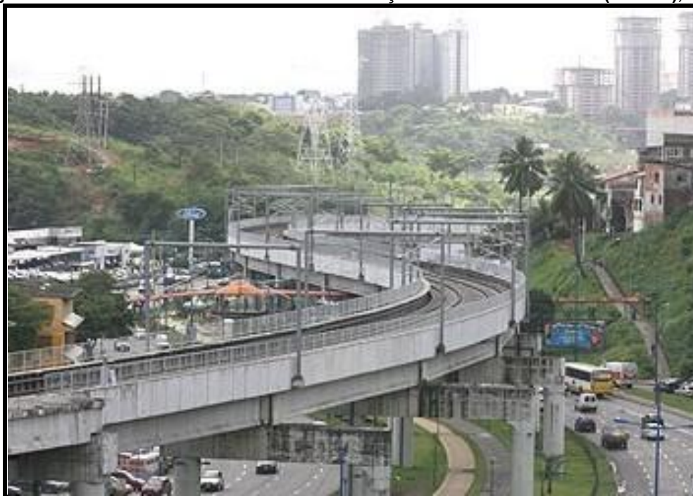
Figura 12 – Metrô de Salvador – Trecho em finalização na Avenida Mário Leal (Bonocô), 2011
