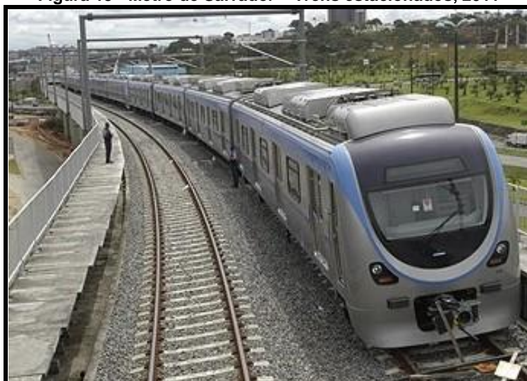
Figura 13 - Metrô de Salvador – Trens estacionados, 2011
