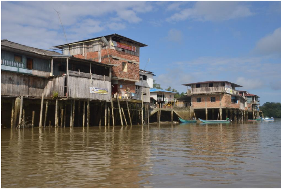
Figura 5. Edificaciones sobre pilotes, Corasal, Timbiquí.
