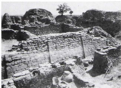
Fig. 26 Casa VIM con muro "aserrado" (Dörpfeld)
