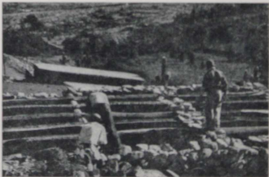
Colocando rollizos y tablas de cardón que sirven de sostén al techo.
