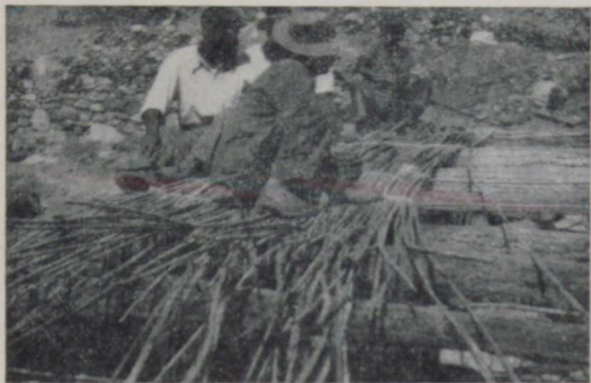
Sobre las vigas de cardón se dispone una capa de cañas atadas entre sí.
