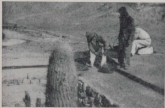
Cubriendo todo la "torta" asegura la impermeabilidad del techo.
