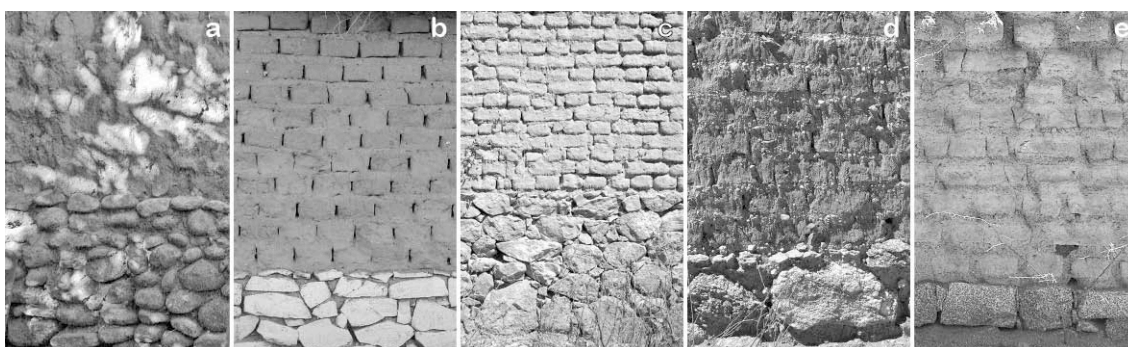
Figura 6.2.11 Algunos tipos de sobrecimientos según su aparejo: a. ordinario o rústico, b. careado, c. careado y enripiado, d. ciclópeo —con un enripiado para regularizar la superficie de apoyo y mejorar el ajuste del muro— y e. concertado. Los cuatro primeros son aparejos irregulares y el último regular. Fuente: Elaboración propia.
