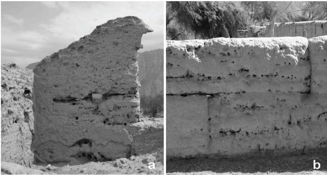
Figura 3.3.5. Muros de tapia. a. Ruinas de Capayán, Famatina, período colonial. b. Muro divisorio de parcela, Santa Ana, Guandacol, período reciente.
