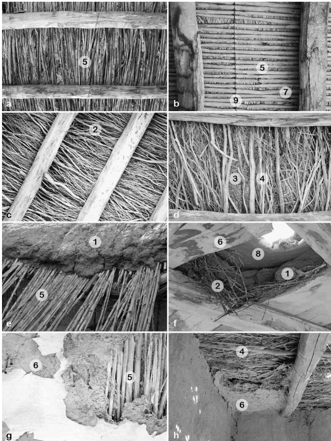
Figura 6.2.24. Distintos ejemplos de las cubiertas y de las capa identificadas. En a. Subtipo A, se aprecia la irregularidad del cañizo al no contener la capa de fijación, b. Subtipo C con la capa de fijación resulta con alambre y la capa de contención de la torta con hojas de cortadera dispuestas en sentido perpendicular al cañizo, c. ejemplo de cubierta pesada con enramada indiferenciada con regularidad en las ramas seleccionadas , d. Subtipo J, se pueden observar la enramada gruesa y la fina con confección irregular, e. Subtipo A vista desde arriba, f. En el ejemplo, subtipo G con cielrroso de tablas y con un retorteadado posterior donde se introdujo la capa hidrófuga, g. Subtipo D con capa de acabado de mortero de barro, h. Subtipo K con restos de la capa de acabado.
