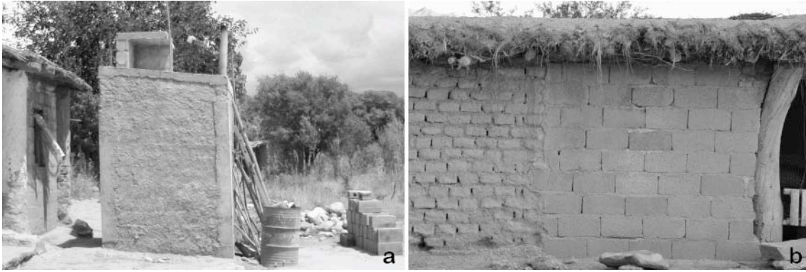
Figura 6.2.9. Uso del cemento en la vivienda rural: a. Ejemplo de construcción de núcleos húmedos por parte del Estado provincial donde se empleó todo un sistema constructivo a base de cemento. b. Un ejemplo de aplicación del cemento como en el caso de los bloques y los morteros de asiento.
