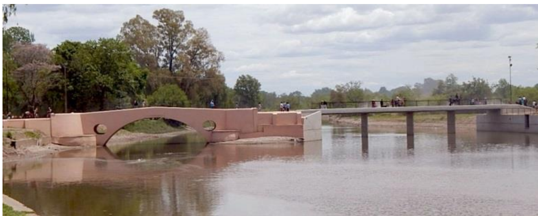
Figura 21. Vista actual del puente Viejo y el aliviador (2015). Autor: Pérez Winter, C.
