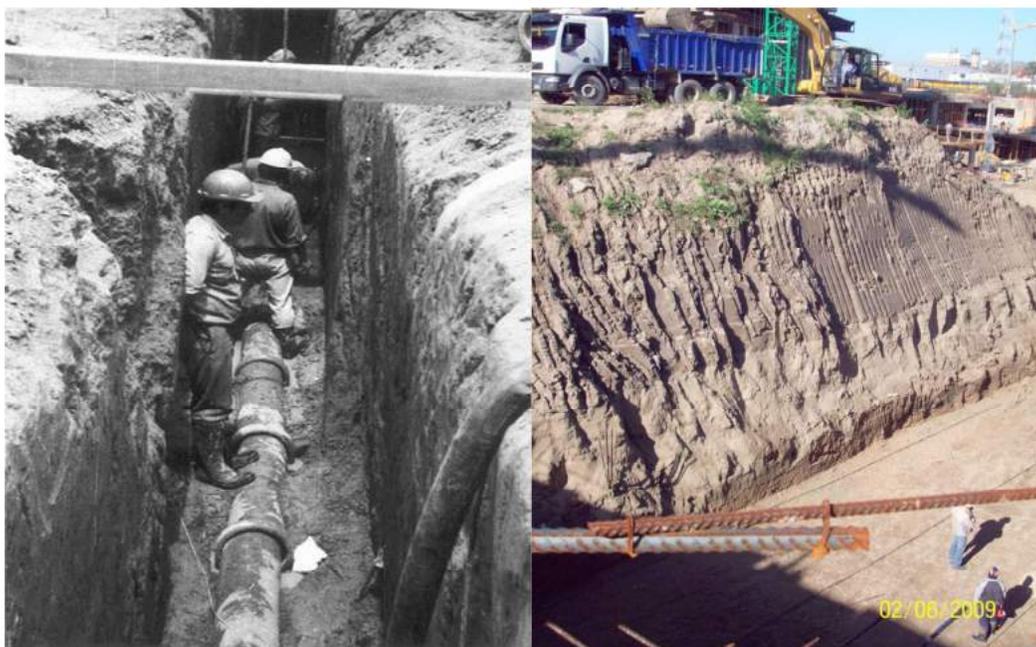
**A la izquierda, obreros instalando cañería de hormigón. A la derecha, movimiento de tierra durante una excavación. Los derrumbes suelen dar lugar a importantes accidentes, en muchos casos, fatales.**
