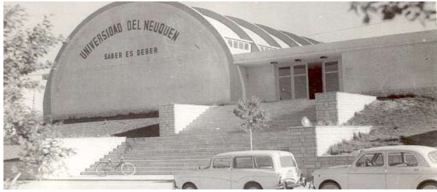
Foto 1 Frente del edificio de la Universidad del Neuquén.
