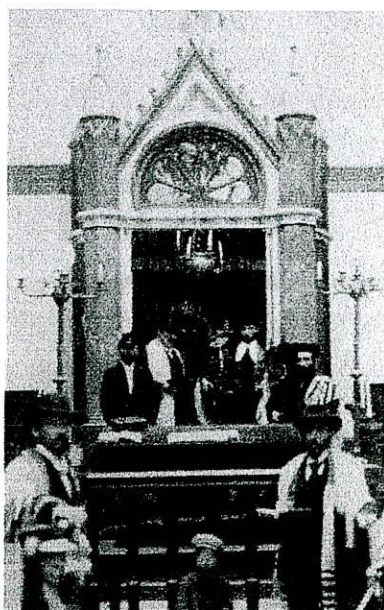
Sinagoga CIRA, interior, Arón Hakodesh (edificio antiguo, demolido)
