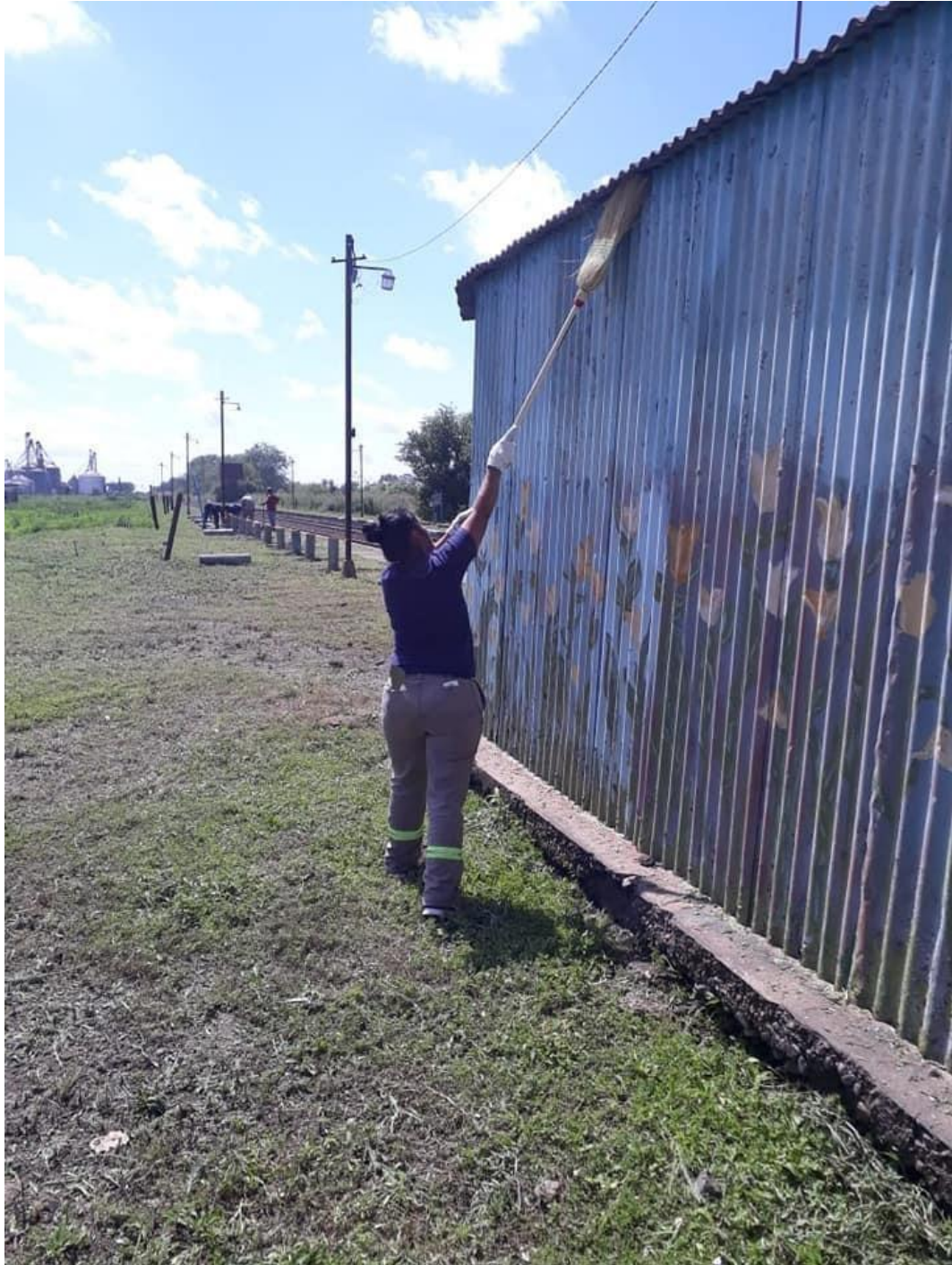
Imagen 4: Trabajadora realizando tareas de mantenimiento en la Línea San Martín.
