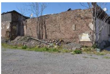
Figuras 5.78. Ejemplo de muro de mampostería de ladrillo en Sector 3, área de estacionamientos, corresponde a hallazgo N° 8 y muro de albañilería en sector 1.
