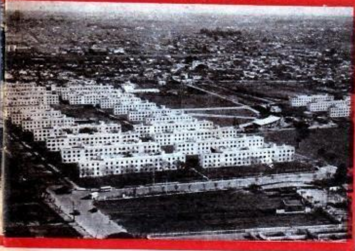
IMPACTO DE LA MISERIA IMPACTO DE LA MISERIA La construcción se detendrá.
