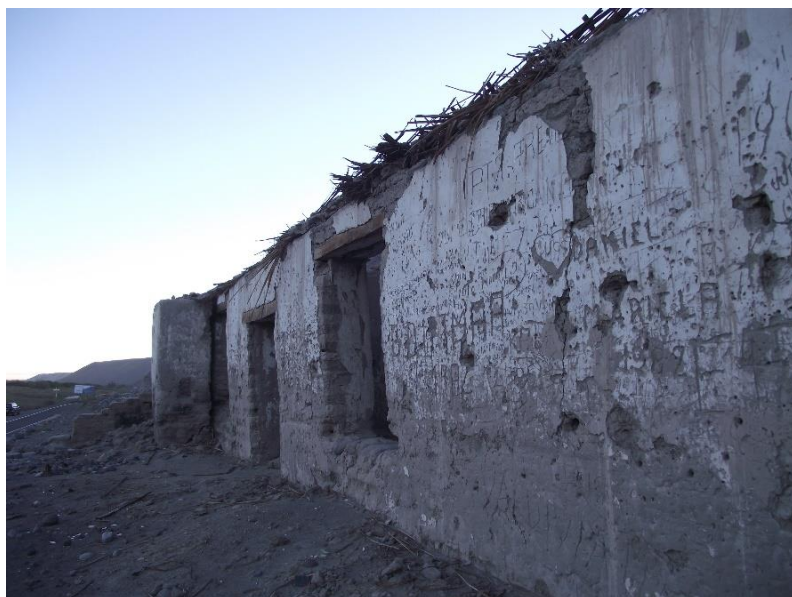
Figura 15. Exterior inmueble principal.
