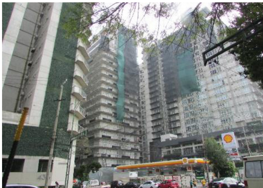
Figura 2. Torres de departamentos City Towers (Xoco). Foto: fotografía propia.
