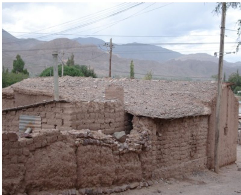
Imagen 11.1. Casa de adobe en Tilcara. Puede observarse el techo de torta
