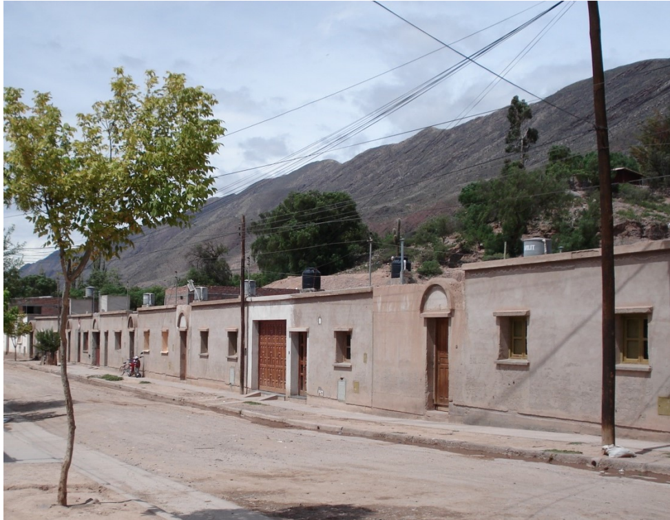
Imagen 11.4. Barrio Malka (Tilcara) construido a partir de un plan de vivienda
