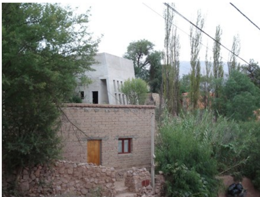
Imagen 12.1. Al fondo, hotel en construcción en el barrio Malka de Tilcara. En primer plano, vivienda donde reside la familia que ocupaba el predio destinado al hotel.
