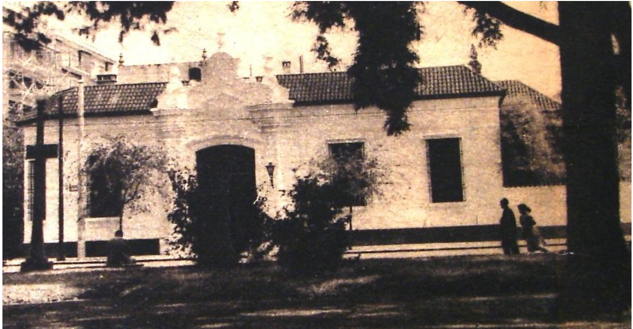
114. Fachada de la casa de Belgrano, sobre Av. Juramento, c. 1960
