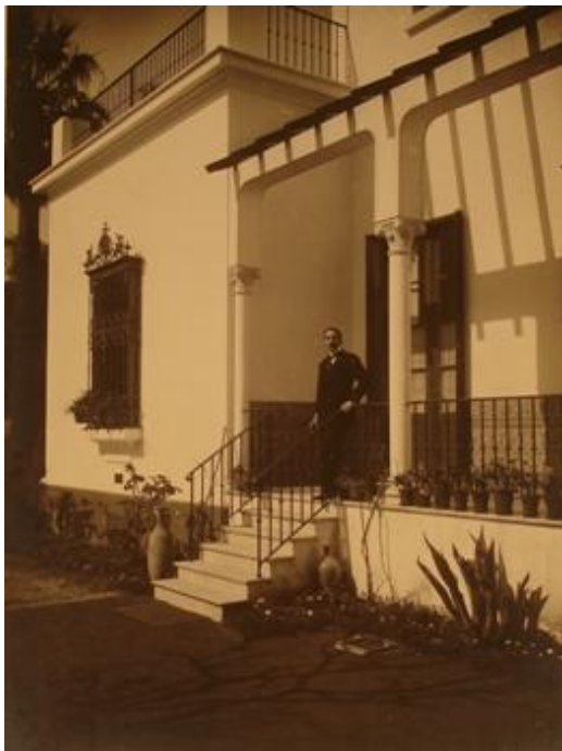
115. Larreta en la galería del Patio de los Naranjos. Se observa que aún no se ha construido el piso superior, c. 1917, AMEL
