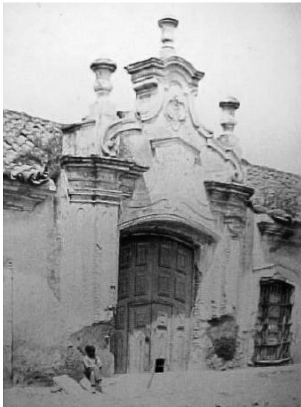
112. Fachada de la Aduana vieja, c. 1880. El edificio se mantuvo hasta los primeros años del siglo XX
