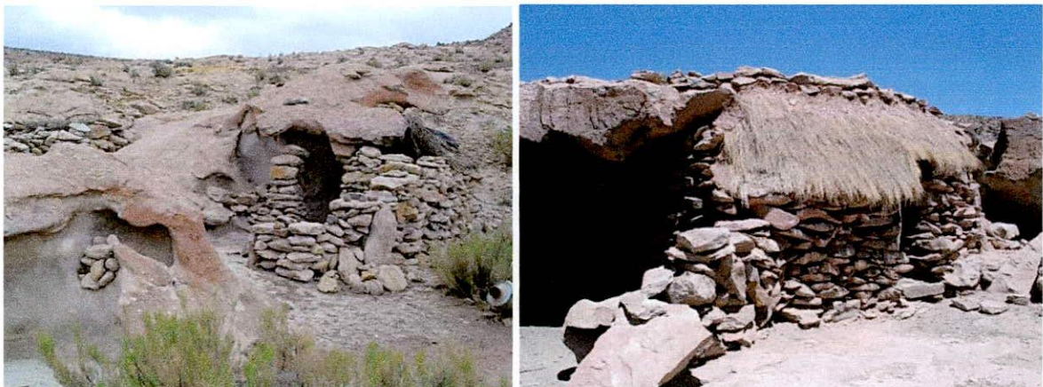
Figuras 6 y 7. Dos estancias en los alrededores de Susques que aprovechan de diferentes maneras sendos aleros de piedra como parte de la cubierta. En la de la derecha, el techo se completó con ramas de tola sueltas, y en el de la izquierda con piedras lajas sobre las que se realizó un guayado .
