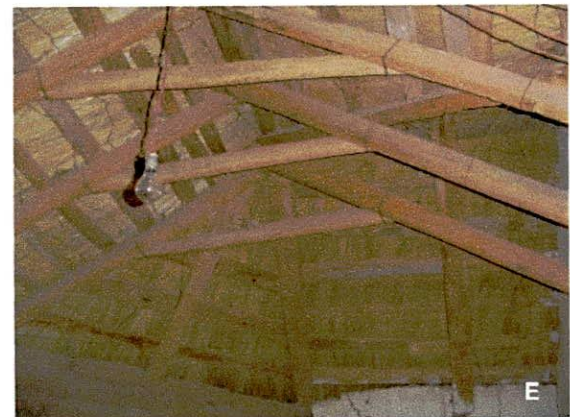
Figura 12. Axonometría general de la casa . (B) Sector del frente de la casa , por la puerta verde se accede al patio ; (C y D) Vistas de dos sectores del patio ; (E) Detalle de las tijeras del techo que sostienen las alfajías y el tejido de paja chillahua (Elaboración propia).
