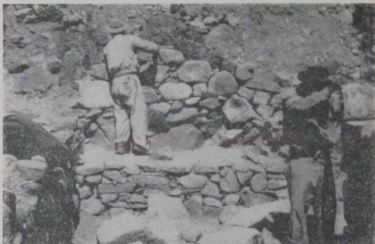
Construcción de las paredes y gradas de piedra de una de las viviendas.
