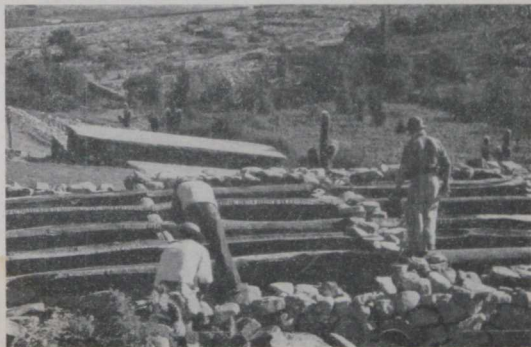
Colocando rollizos y tablas de cardón que sirven de sostén al techo.
