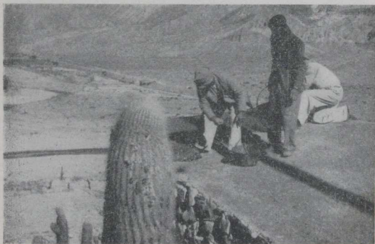
Cubriendo todo la "torta" asegura la impermeabilidad del techo.
