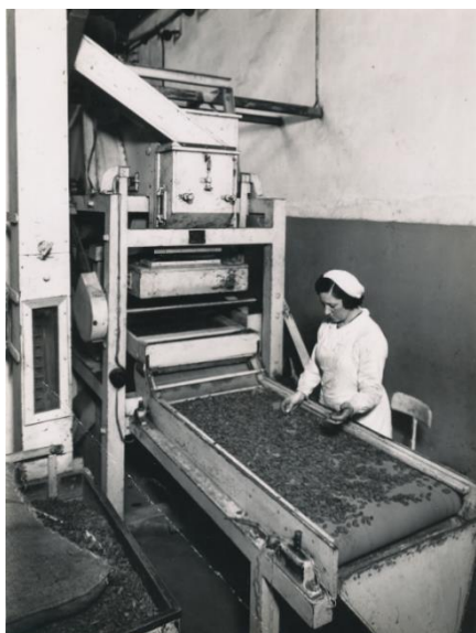
Foto 8 Los granos de cacao ya desinfectados, pasaban por la máquina limpiadora, supervisados por una experta operaria. Noel, 1939. Documentos Fotográficos, AGN.
