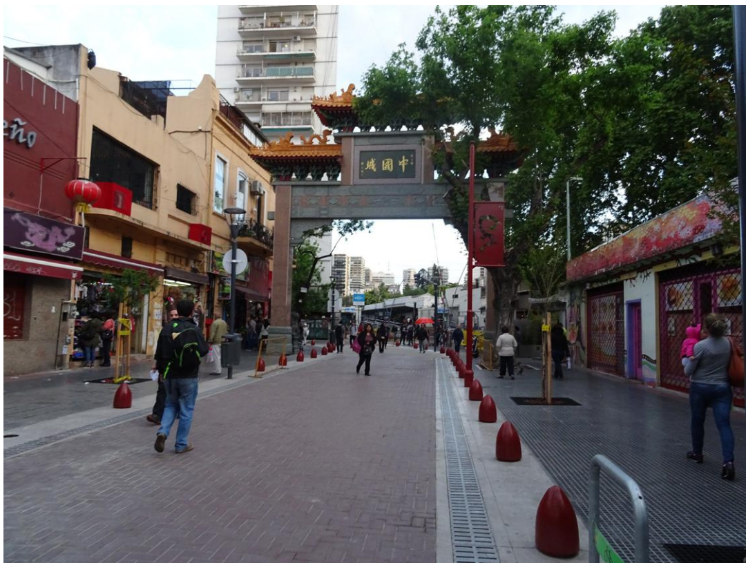
“Obras peatonalización y puesta en valor” (2016). Foto: Soledad Laborde
