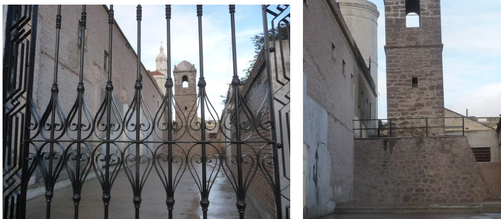
Figura 18a y 18b: Vista de la torre del fuerte. Detalle de la torre con la base construida a principios de siglo XX.
