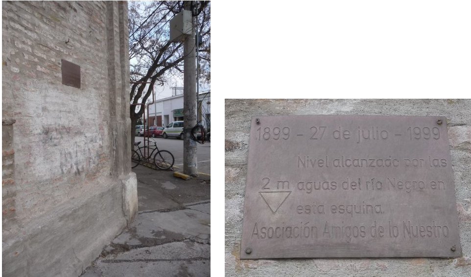
Figura 30a y 30b: Placa colocada en la “manzana histórica” de Viedma para indicar los dos metros de agua que mantuvieron inundada a la ciudad.
