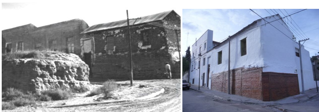
Figura 43a y 43b: Imagen de la vivienda antes y después de ser restaurada. Fuente fotografía antigua: Subdirección de Patrimonio Histórico de la Municipalidad de Carmen de Patagones.
