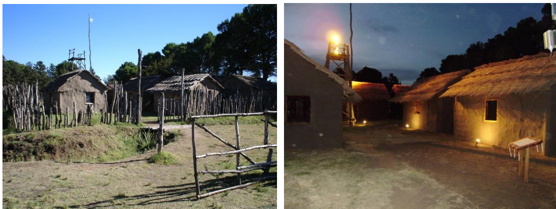
Figura 34a y 34b: El Fortín Pavón en 2006, a la derecha la restauración finalizada (enero de 2012).
