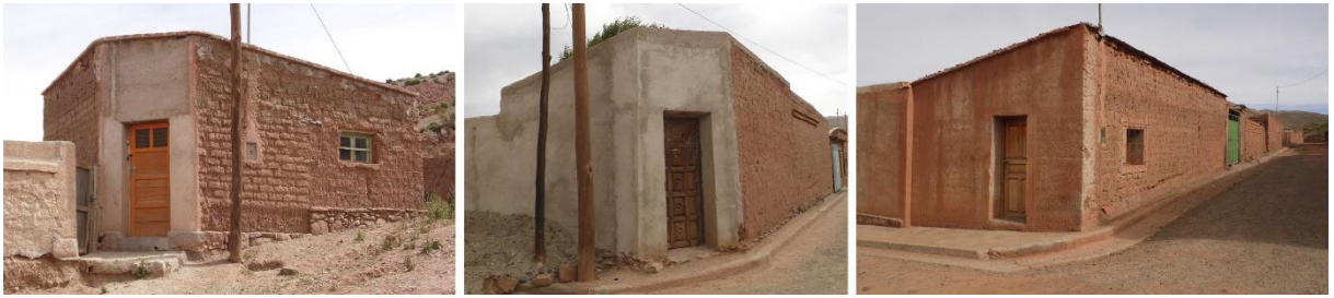
Figura 4.83. Utilización de revoques de cemento en ciertas caras de las fachadas, particularmente ochavas (Fuente: fotografías propias).
