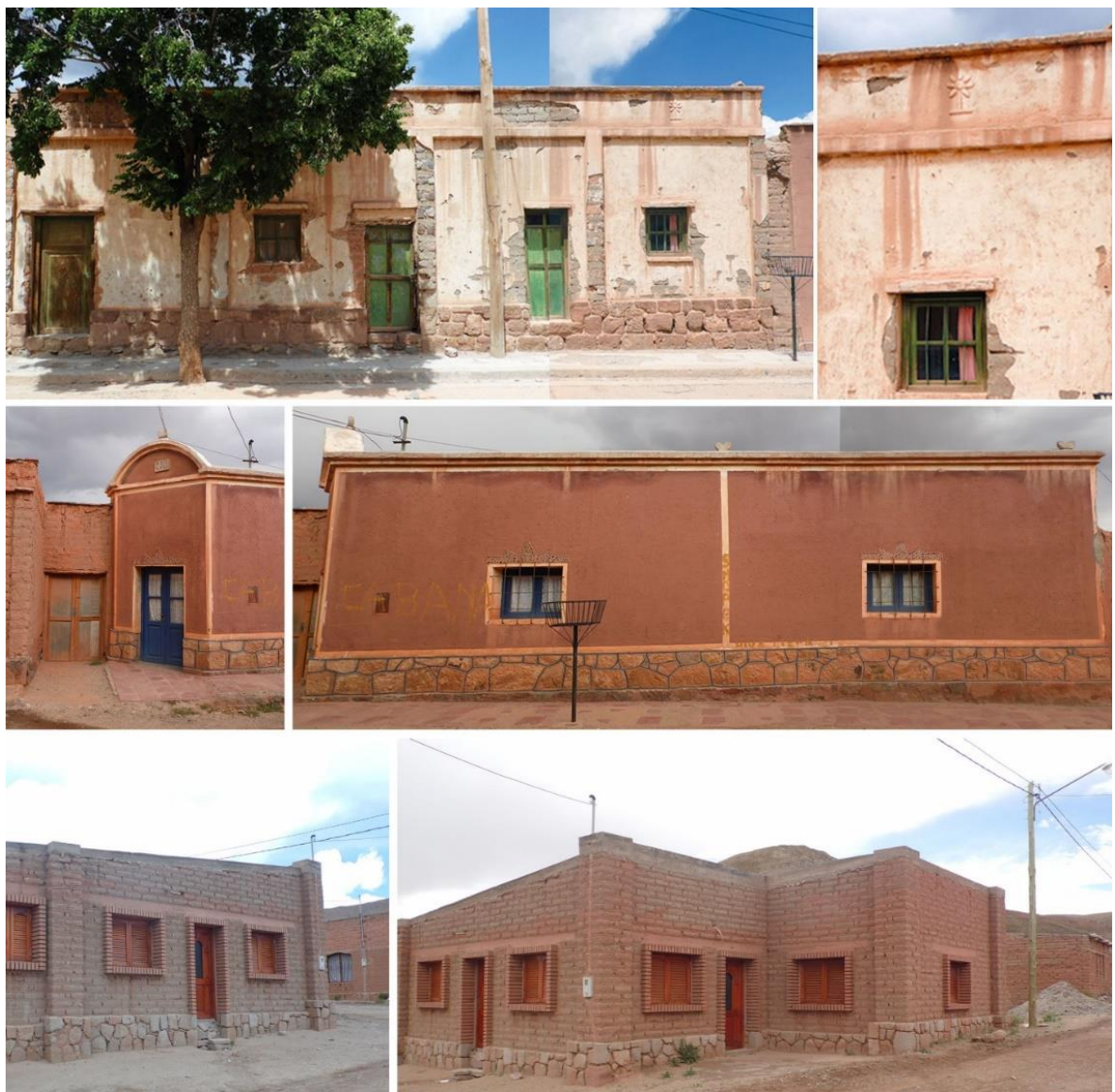
Figura 4.74. Trabajos en fachada en la actualidad: se observan cornisas, frisos y detalles ornamentales sobre dinteles. La imagen de arriba corresponde a una de las casas más antiguas localizadas sobre la
