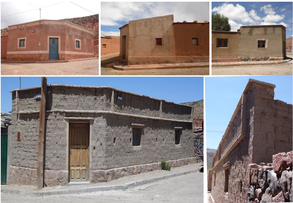
Figura 4.75. Frentes que funcionan como ‘fachadas telón’ ocultando la resolución del techado hacia la calle (Fuente: fotografías propias).
