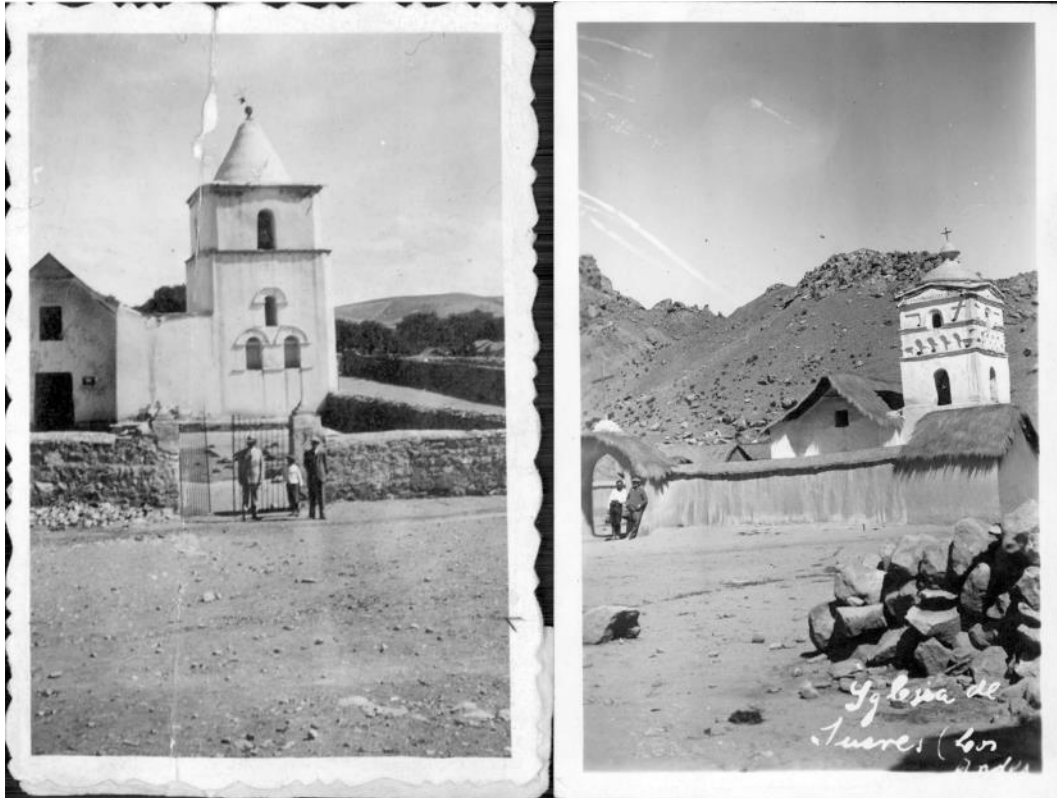
Figura 4.45. Postales de otras iglesias del área. A la izquierda, imagen de la Iglesia de La Quiaca en 1939 y a la derecha, la de Susques en 1930, ambas con el campanario en una torre lateral (Fuente: Archivo General de la Nación. Departamento de Documentos Fotográficos).
