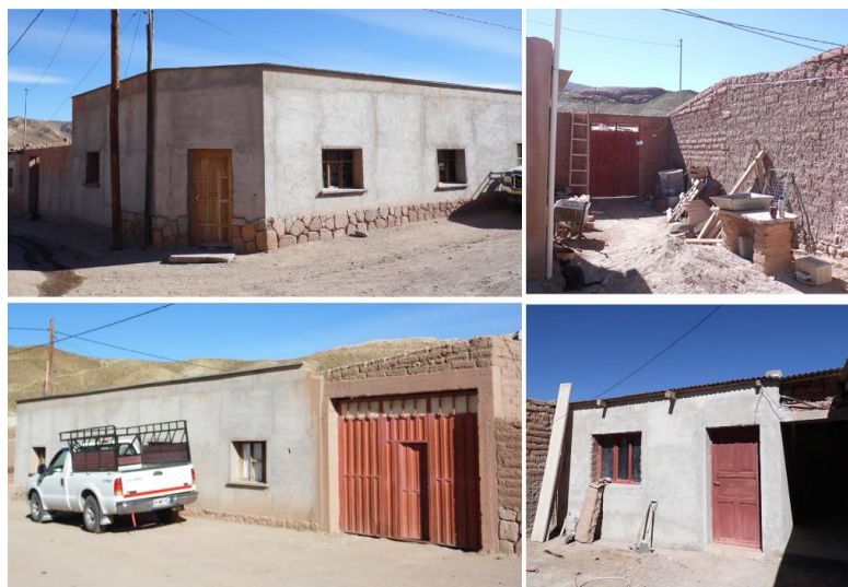
Figura 4.66. Imágenes de la casa de Nancy. A la izquierda superior se observa el acceso al departamento, en ochava y abajo el acceso lateral al garaje. En la columna derecha el patio y abajo, la casa de los chicos (Fuente: fotografías propias).
