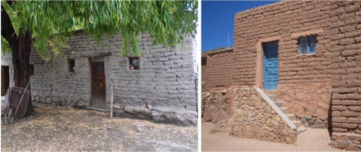
Figura 4.33. Muros de adobe en las construcciones: (izq.) en una casa en el campo en la sección Agua Delgada , en Coranzulí y (der.) en una casa en el pueblo (Fuente: fotografías propias).
