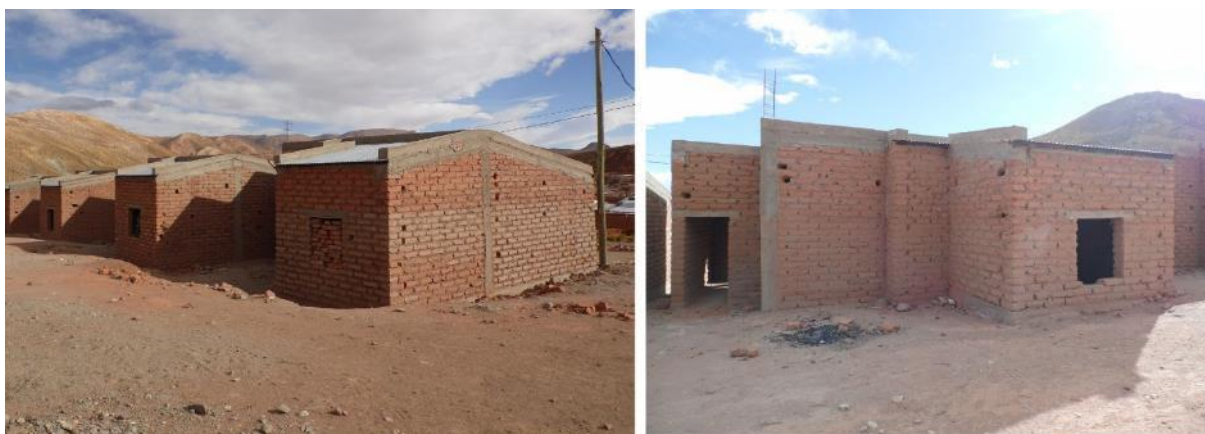
Figura 4.69. Viviendas en proceso de construcción en 2016 en el nuevo loteo de La Banda (Fuente: fotografías propias).
