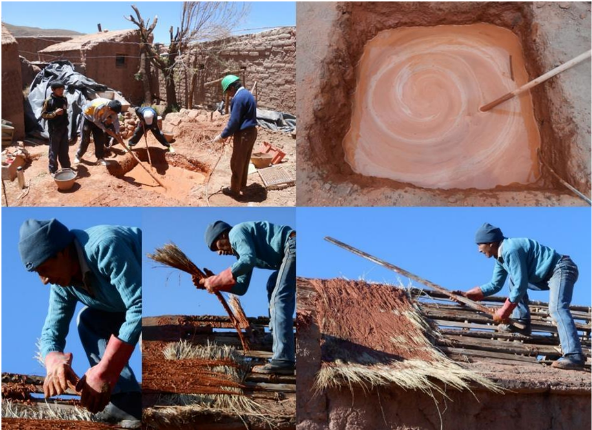
Figura 4.37. Tareas en el guayado de una casa en Coranzulí. Arriba la preparación del barro y el pozo, abajo la secuencia de colocación de los manojos de paja por un maestro constructor (Fuente: fotografías propias).
