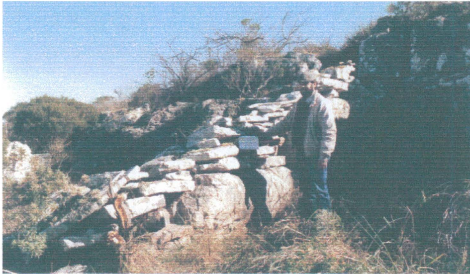
Figura 32. Detalle de la construcción de los cerramientos y sector del sondeo interno.
