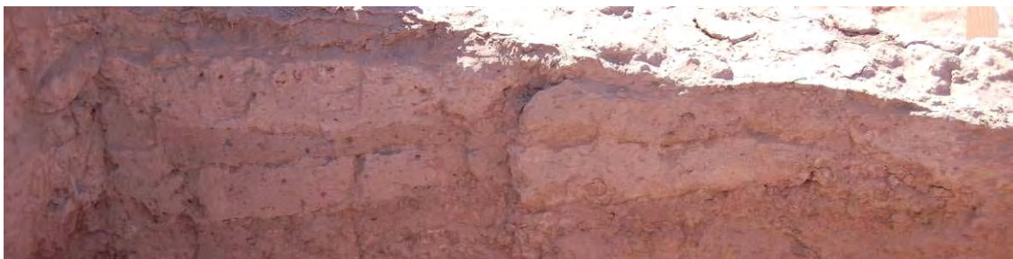
Figura 8.22. Detalle de la mampostería de adobe en el aparejo interno del muro nordeste de R3.
