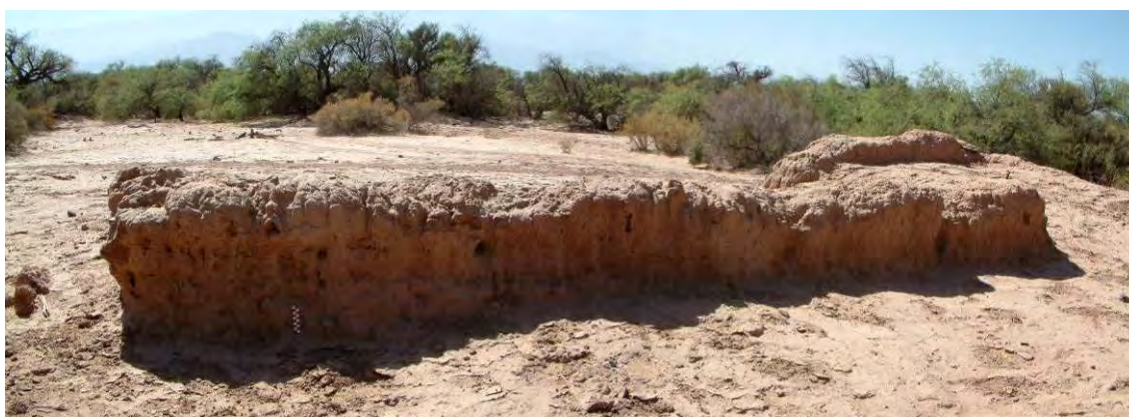
Figura 8.20. Vista de un tramo del aparejo exterior del muro noroeste de R3.
