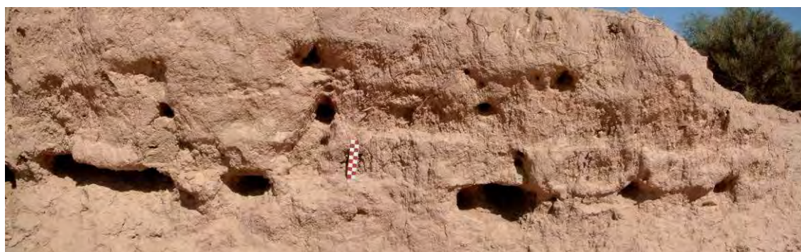
Figura 8.21. Detalle de la mampostería de adobe del aparejo exterior del muro sudeste de R3.
