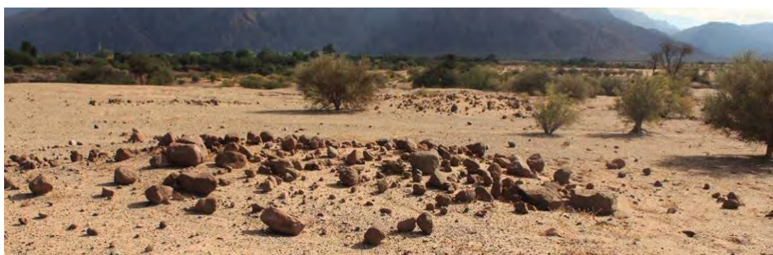
Figura 7.8. Detalle del estado de conservación de las estructuras arquitectónicas de Las Eras Viejas.
