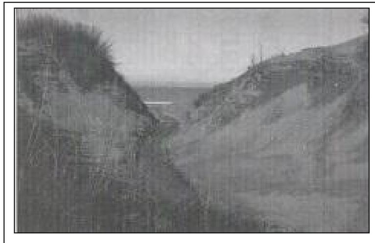
Figura 5.1.o: Apertura y corte del médano frontal a la altura de la Calle 44 para la posterior construcción del túnel submedanal
