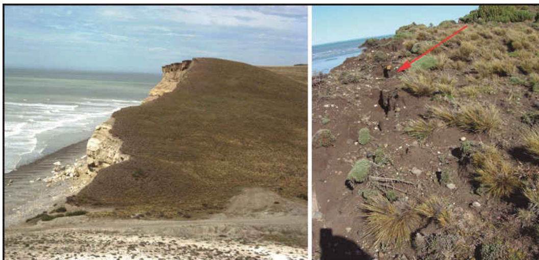
Figura 4.3. Izquierda: acantilados de Cabo Espíritu Santo, nótese el contacto activo con el oleaje y las caídas de bloque de las escarpas. Derecha: vista desde arriba del barranco del sector correspondiente a la desembocadura de Cañadón Alfa, nótese las grietas previas al desmoronamiento. Fotos cortesía de Karen Borrazzo.
