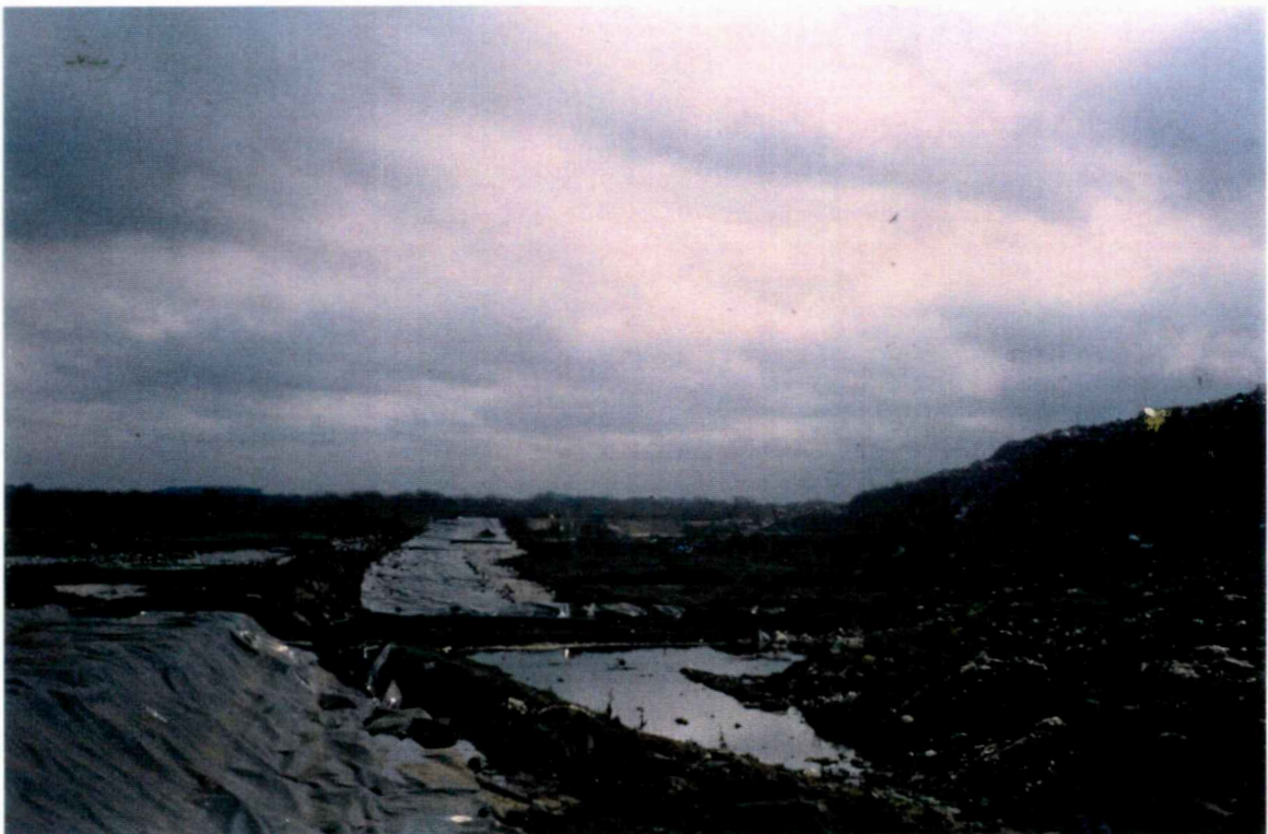
FOTO N° 14. CDF NORTE III. TAREAS DE IMPERMEABILIZACION
