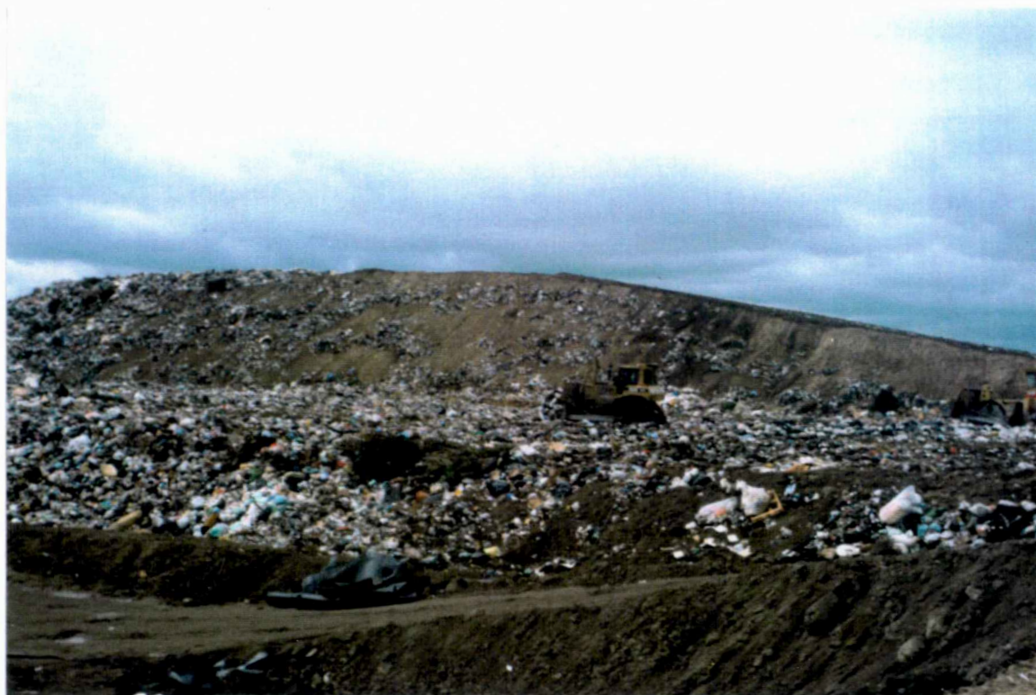
FOTO N° 11. CDF NORTE III. MAQUINARIA EN FRENTE DE TRABAJO
