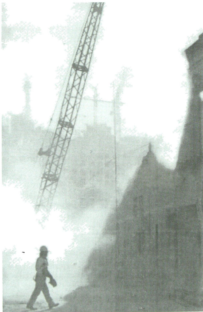
Foto 1 Demolición de una casa durante el proceso de reciclaje barrial
