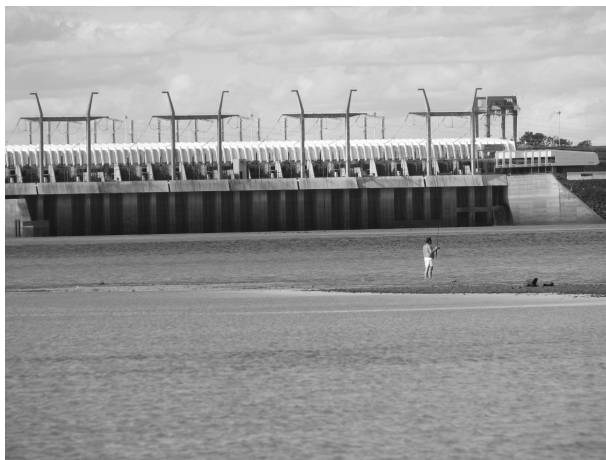
Foto N°2: Represa Hidroeléctrica de Salto Grande.
