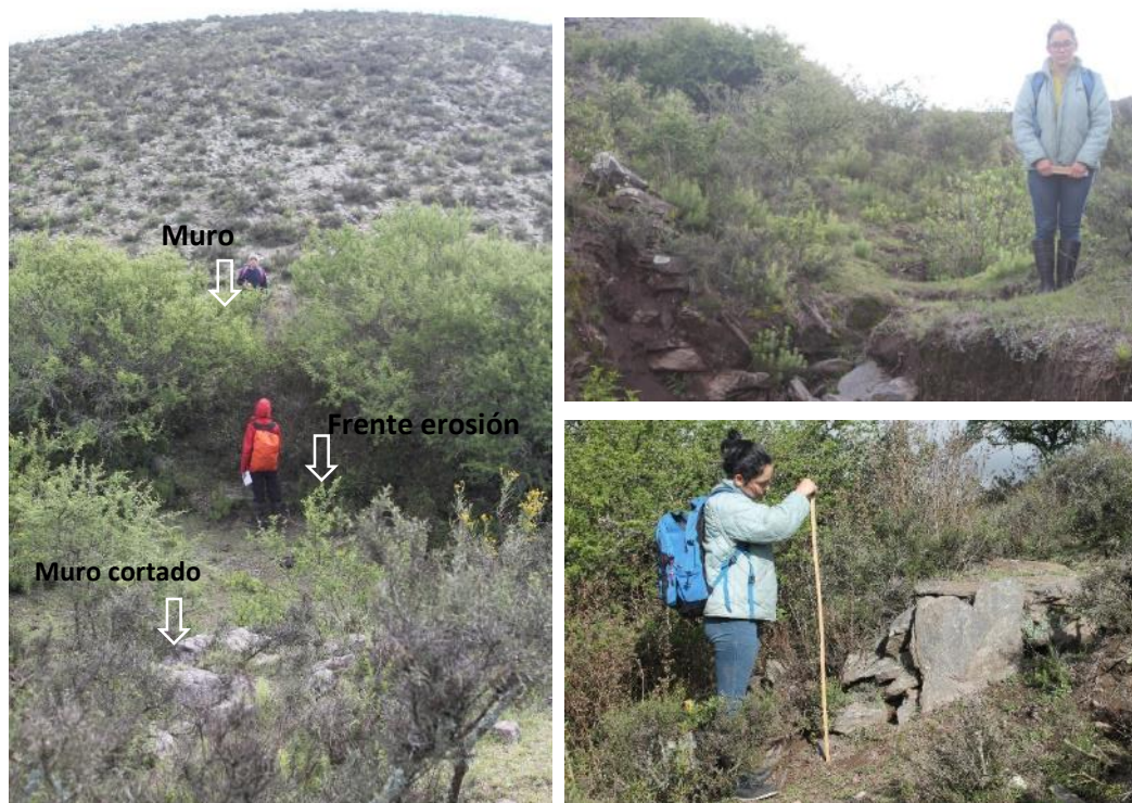
1Figura 7.37. Relevamiento de estructuras afectadas por la erosión en el sector medio
