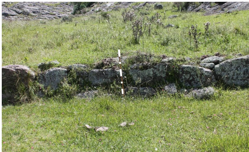
Figura 5.29. Detalle mampostería del muro de la terraza 164, el metro resaltado en blanca destaca la escala (75 cm)
