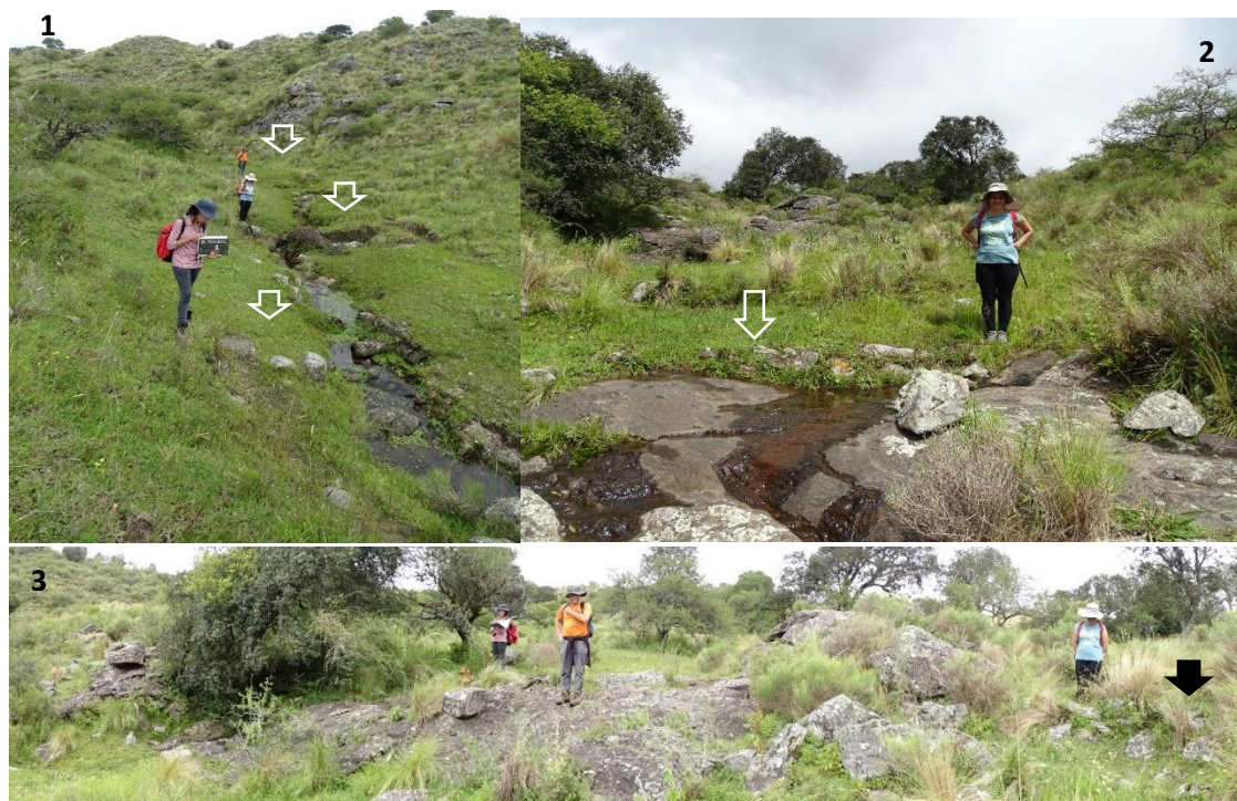
Figura 5.80. Terrazas erosionadas en la desembocadura de la quebrada. 2) Muro apoyado sobre afloramiento. 3) Panorámica área aterrizada aprovechando grandes afloramientos, sector cota alta desde sitio PLM 7 -T258- flecha negra marca muro vegetado.
