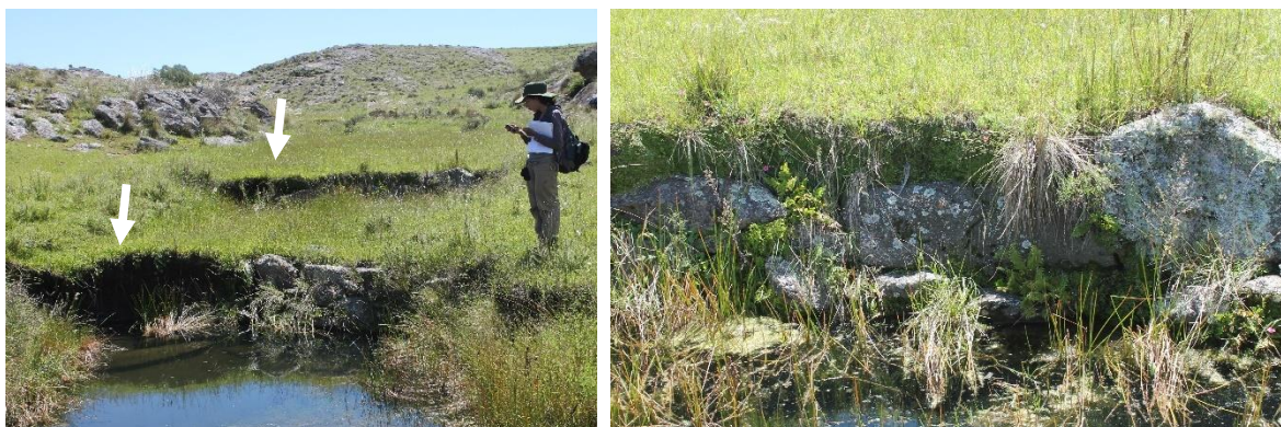
Figura 5.30. Detalle estructuras erosionadas, pueden observarse ls desprendimientos de bloques y el perfil expuesto. A la derecha pueden observarse bloques voluminosos conformando la mampostería
