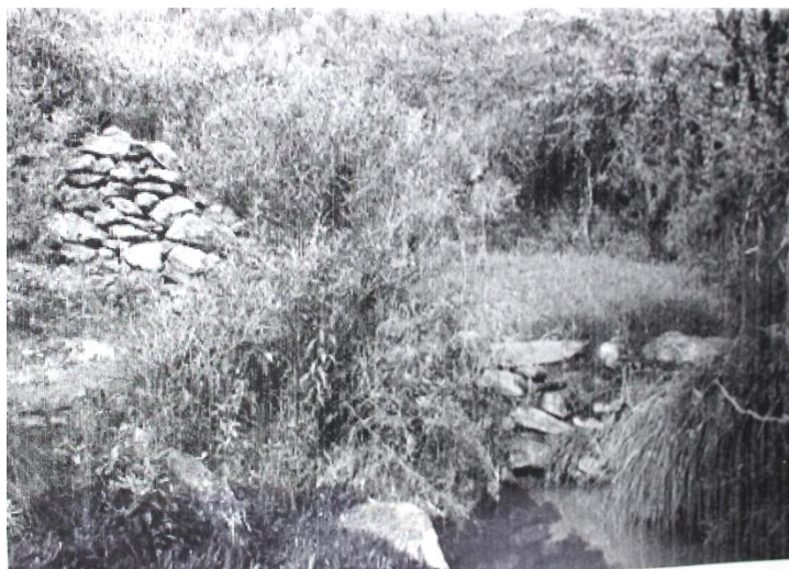
Figura 2.8: Muros de contención con vertiente saliente en la Quebrada de El Tala (Puentes 1998)
