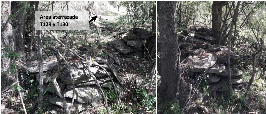
Figura 6.33. Muro 131, al final de la zona aterrizada, frente y perfil
