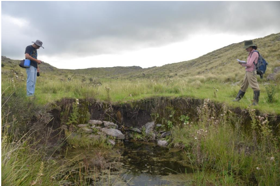
Figura 5.16. Terraza n°76, con procesos erosivos, derrumbe de muro y vertiente visible
