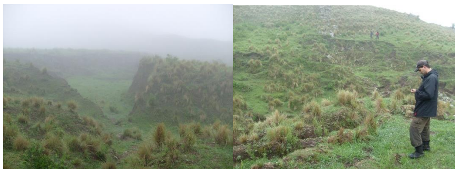
Figura 5.3. Formación de profundas cárcavas y procesos de remoción en masa en las quebradas prospectadas en 2011.
