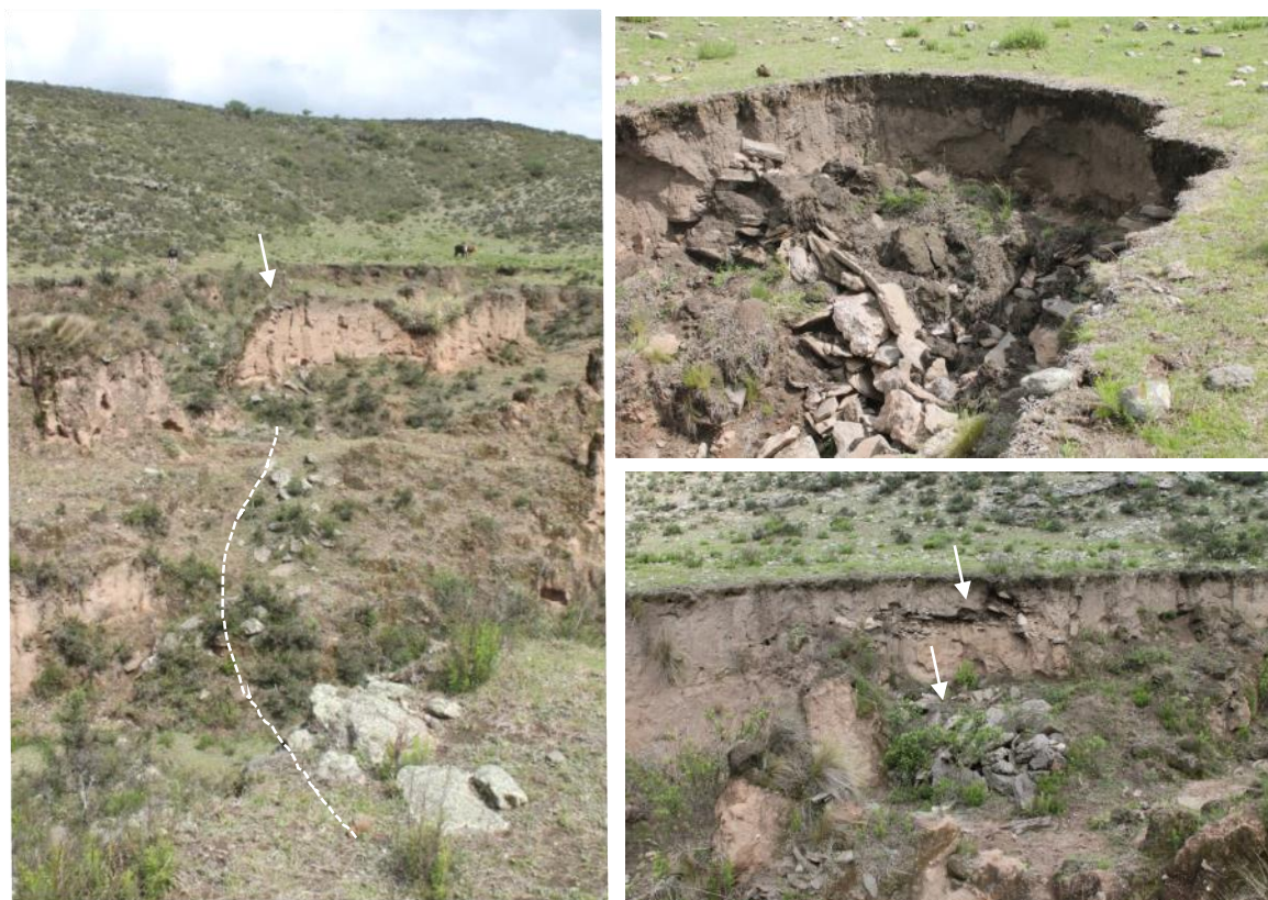
Figura 7.39. Registro de procesos erosivos post-abandono de subsidencia. La línea punteada y la flecha indican los muros
