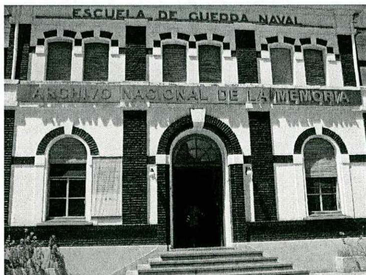
Fotografía del edificio cedido al ANM en el predio de la “ESMA”, año 2009.
